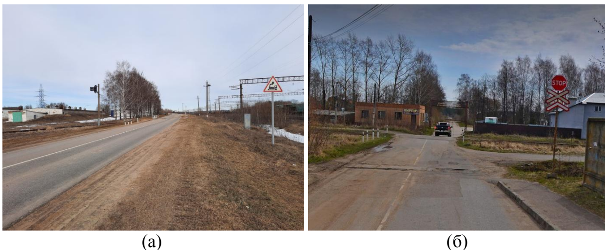
Рисунок 1.14 – Железнодорожные переезды г.о. Зарайск: а – на АДОПММЗ 46Н-02541 «Карино – Макеево – Печерники»; б – на АДОПМЗ «Автомобильная дорога г. Зарайск ул. подъезд к ЗСМ»
