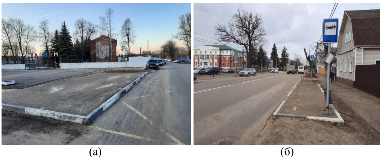
Рисунок 1.18 – ОП г. Зарайск без павильона: а – на ул. Привокзальная; б – на ул. Димитра Благоева
