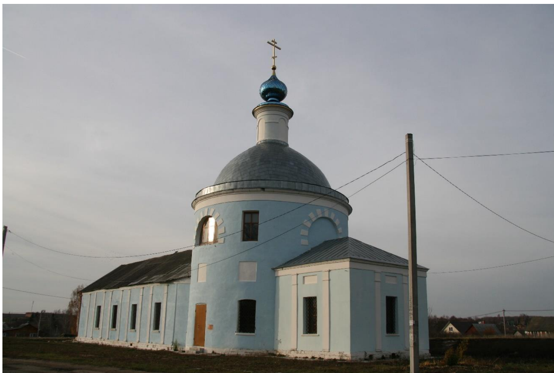
Деревня Карино. Церковь Смоленской иконы Божией Матери, 1824-1839гг. (после проведения работ)
