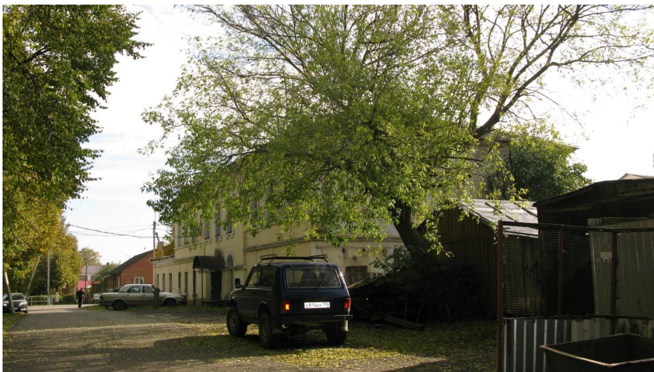
Здание городского казначейства, 1-я пол. XIXв. Вид с северо – запада.
