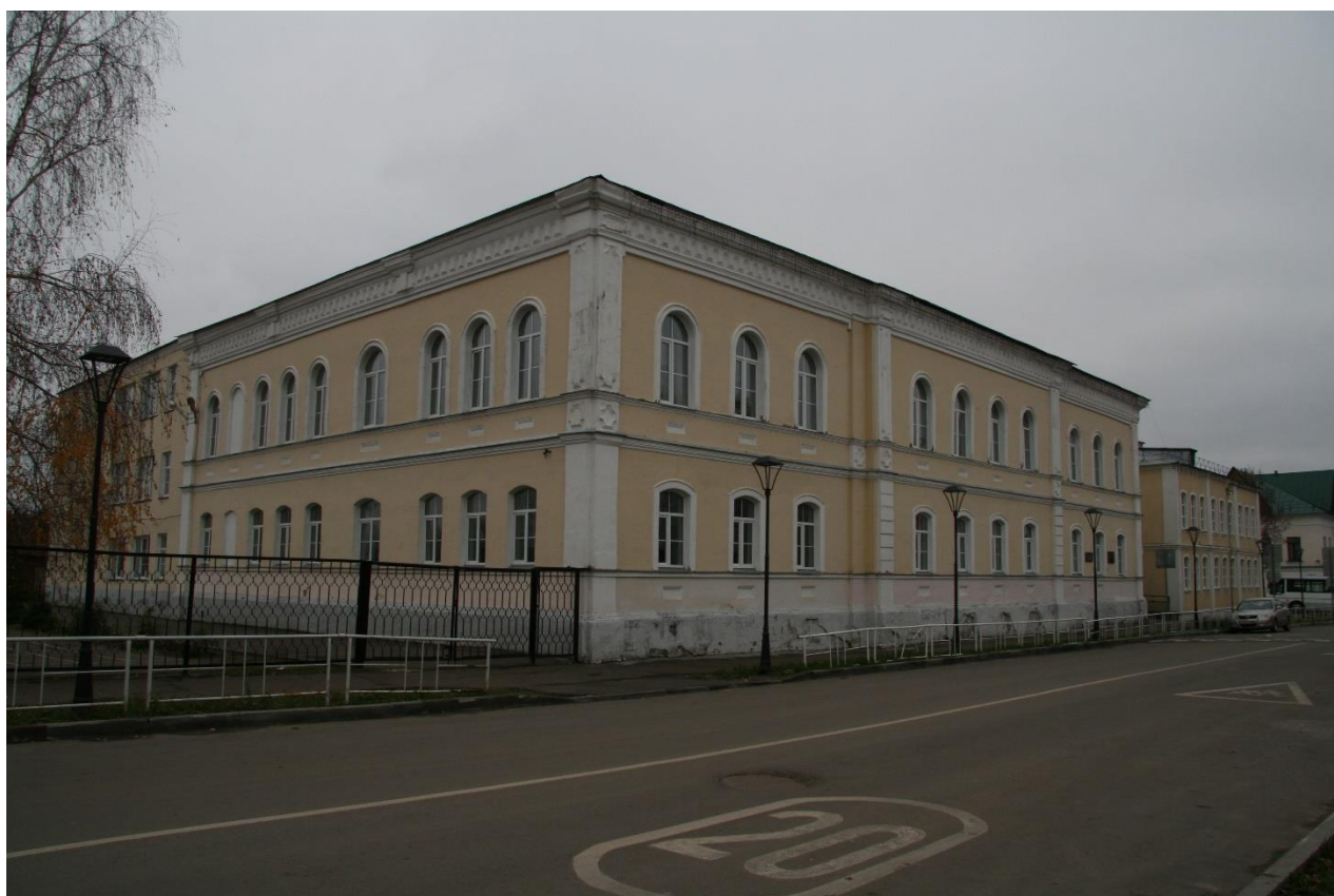
г. Зарайск, ул. Красноармейская, д. 31. Здание бывшего реального училища
