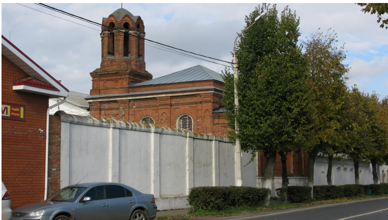
Церковь Николая Чудотворца, нач. XX в. Вид с юго – востока, с ул. Карла Маркса.
