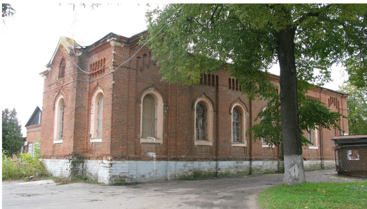
Церковь Казанской иконы Божией Матери, нач. XX в. Вид с северов – востока, со двора.
