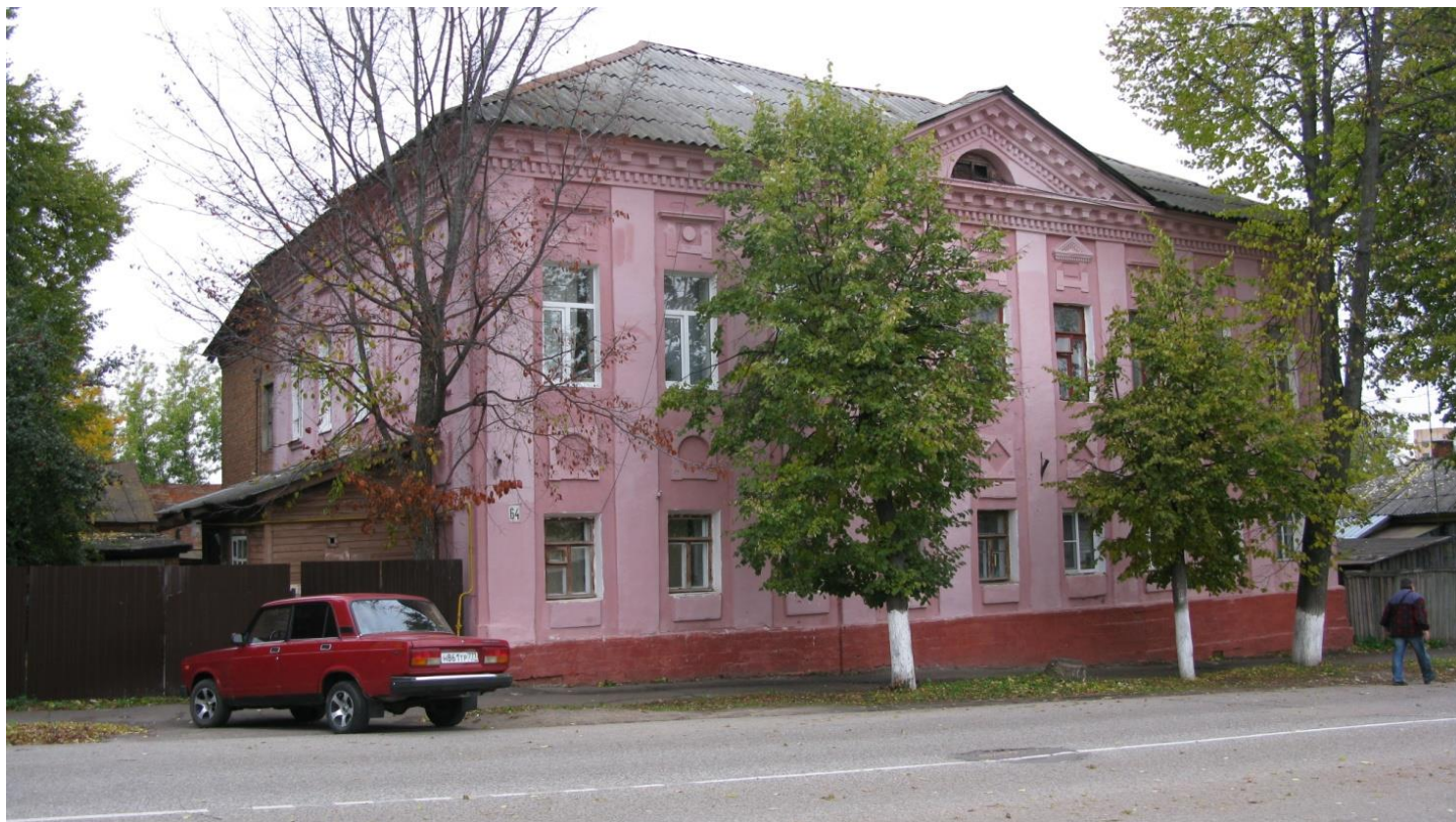
Дом жилой, кон. XVIII-XIX вв. Вид с юго – востока, с ул. Держинского.
