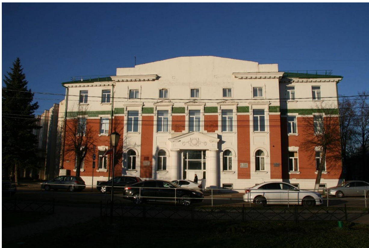
Здание Зарайского земства, 1910г. Вид с юго - запада.
