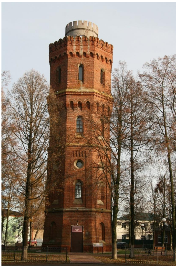
Башня водонапорная, 1914г.
