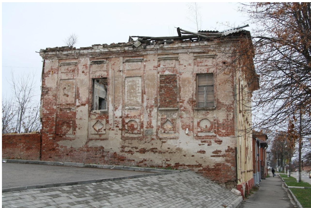
Дом жилой, кон. XVII в. Вид с севера, ул. Первомайская.
