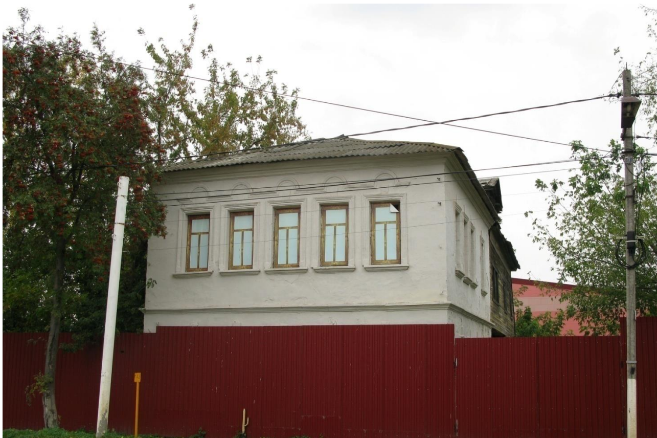
Дом жилой, перв. пол. XIX в., вт. пол. XIX в. Вид с запада, с ул. Дзержинского.
