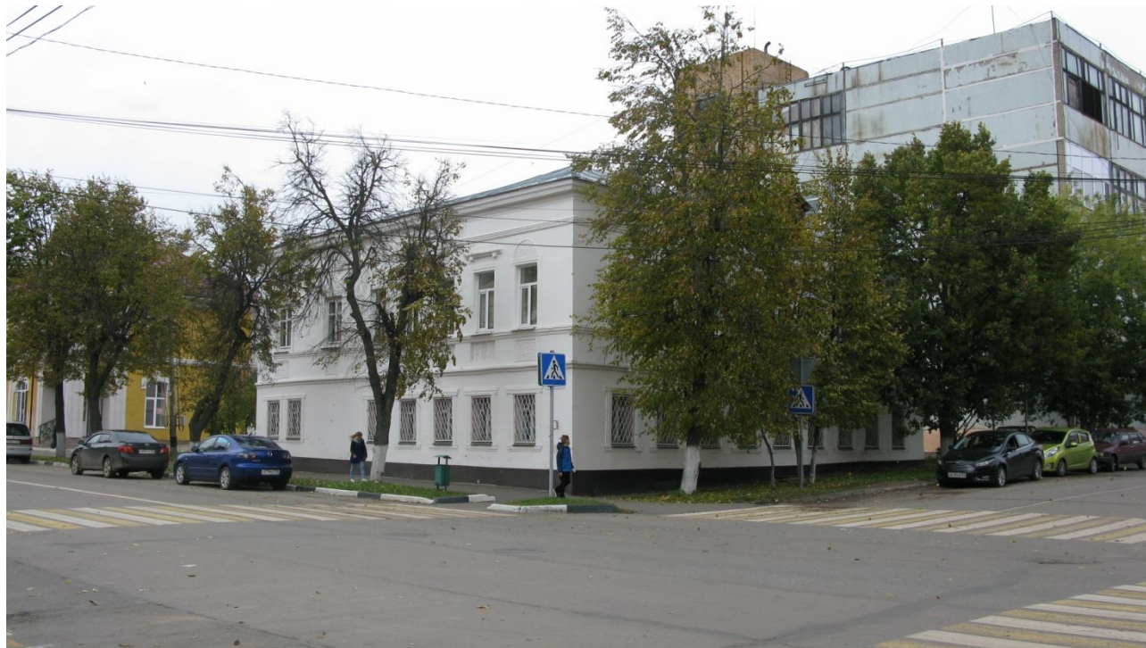
Дом жилой, нач. XIX в. Вид с юго – востока, с пересечения ул. Советская и ул. Мерецкова.
