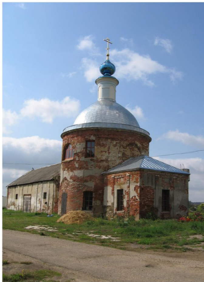
Деревня Карино. Церковь Смоленской иконы Божией Матери, 1824-1839гг. (до проведения работ)
