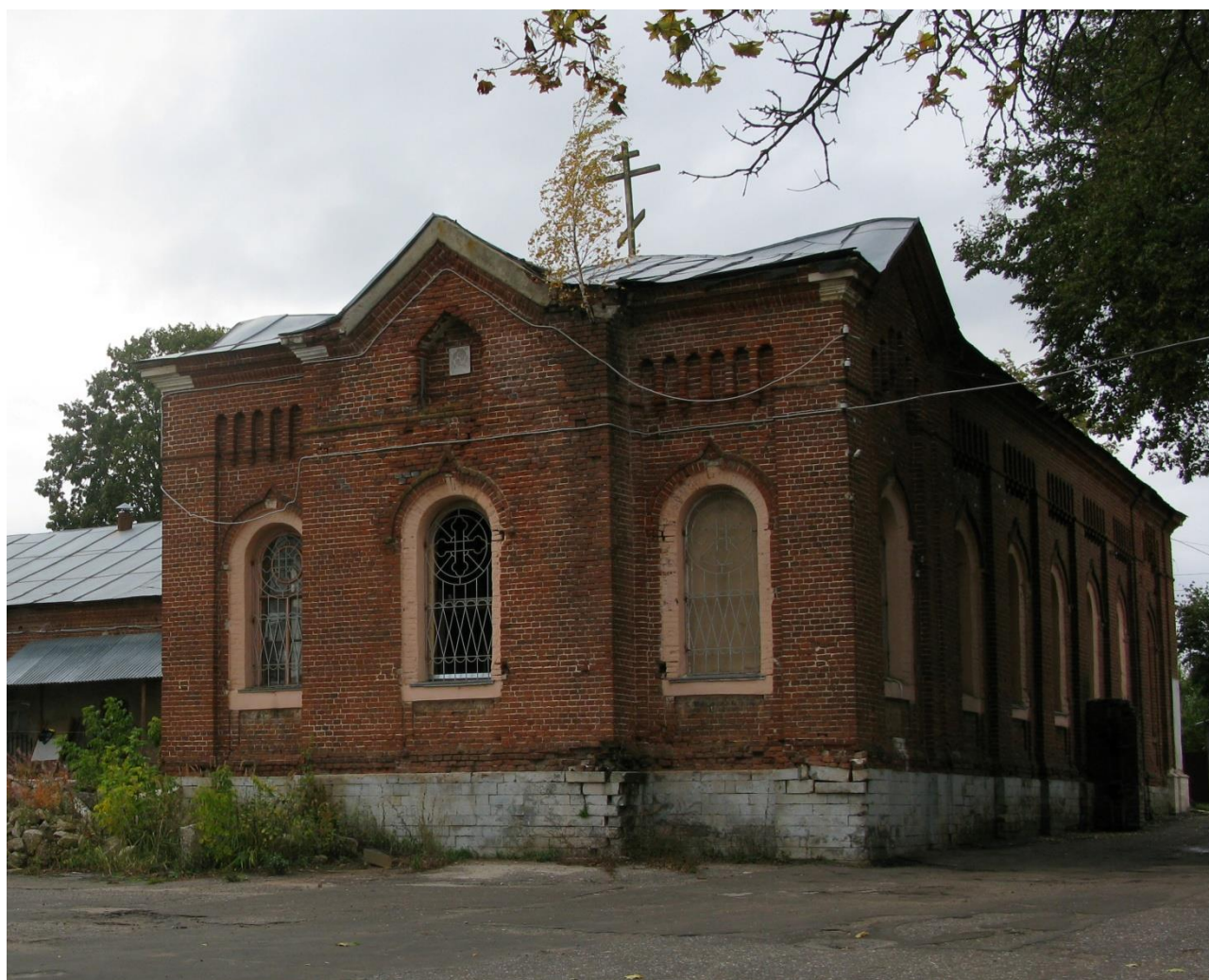
Церковь Казанской иконы Божией Матери, нач. XX в. Вид с северов – востока, со двора.
