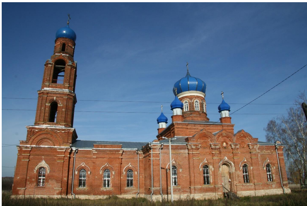
Клин-Бельдин. Церковь Благовещенья Пресвятой Богородицы, 1907г.(после проведения работ)
