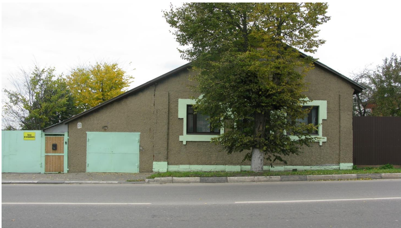
Вид с востока, с ул. Первомайская.
