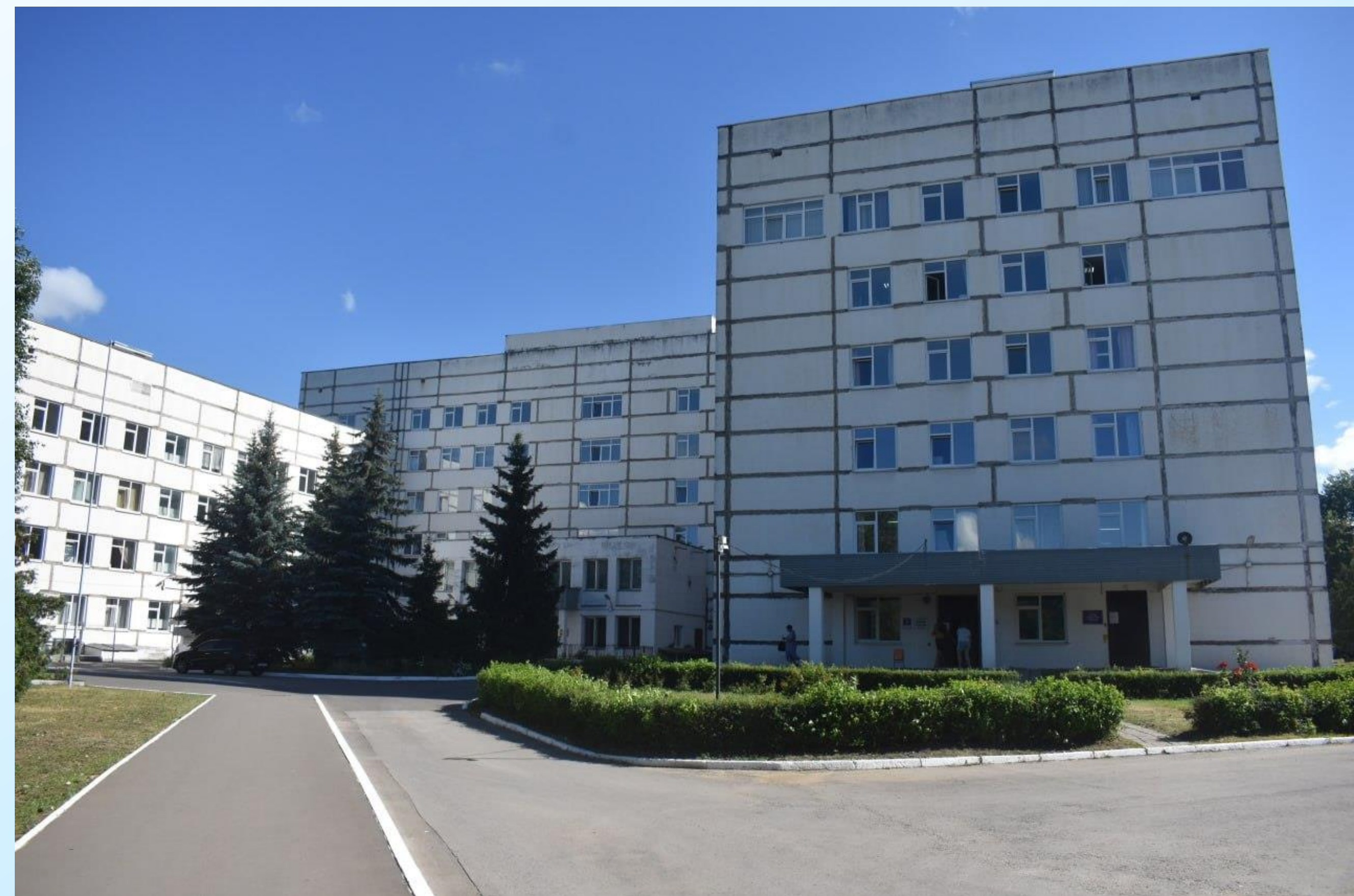
Капитальный ремонт главного корпуса Зарайской ЦРБ г. Зарайск, ул. Октябрьская, д. 5
