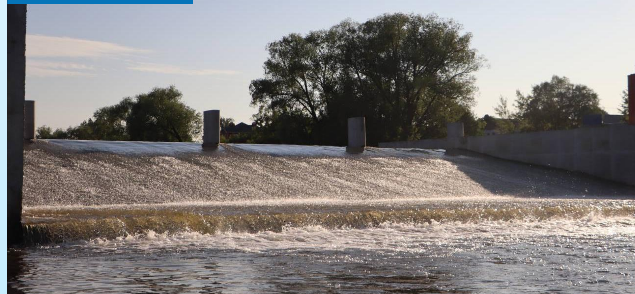
Плотина на р. Осётр
