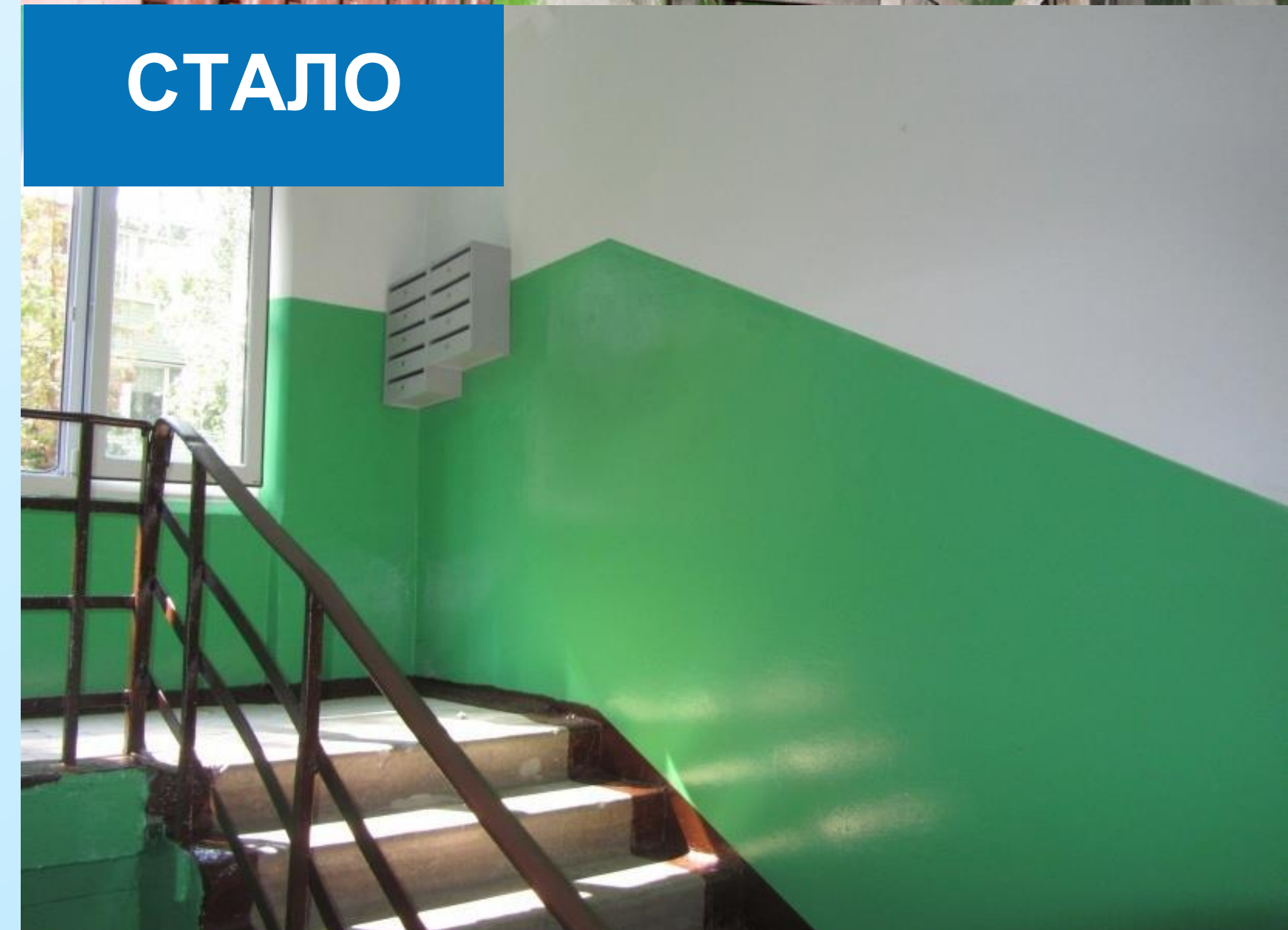
Ремонт в подъезде в д. Ерново д. Ерново, д. 1
